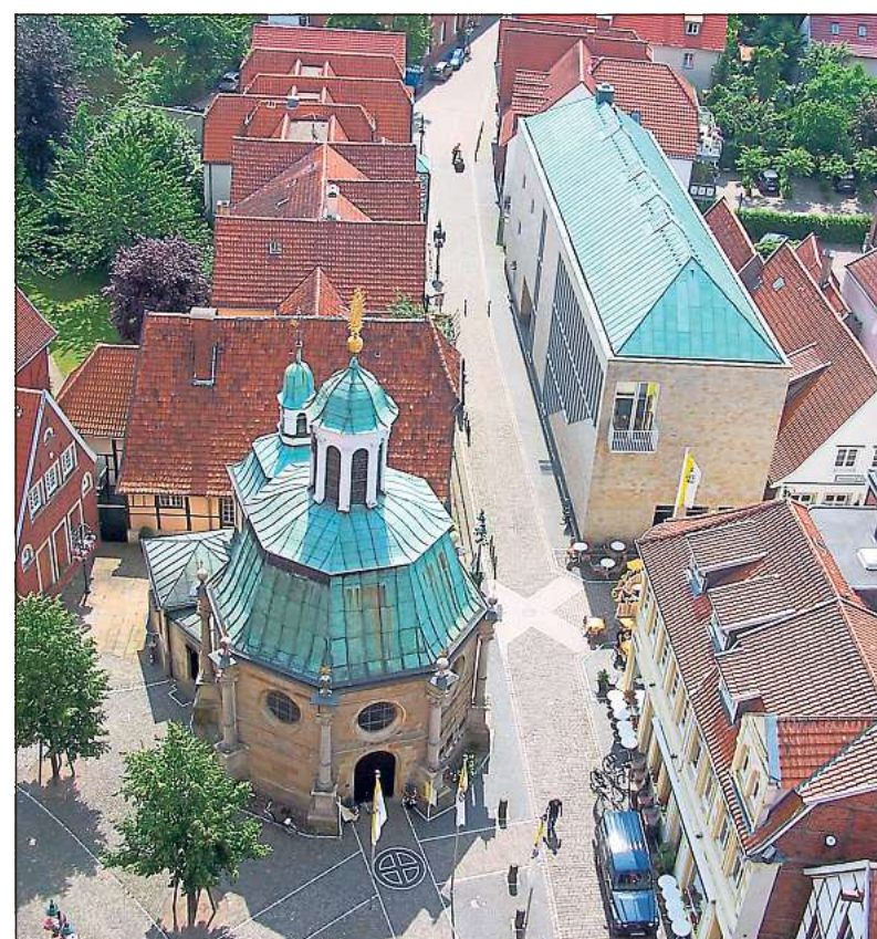
100 000 Euro stehen für die Sanierung der Außenfassade des Museums Religio in Telgte in diesem Jahr zur Verfügung.
